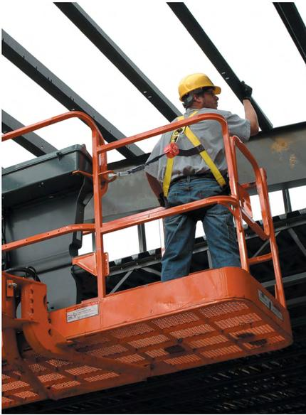
Montacargas aéreo con barandas de seguridad
